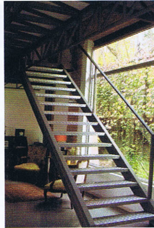
Abierta, de hierro, con escalones de chapa. La baranda tiene tensores de acero y el pasamanos es de hierro.
